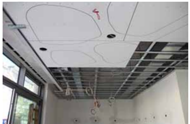
Decke nach dem Verspachteln und Schleifen der Fugen
