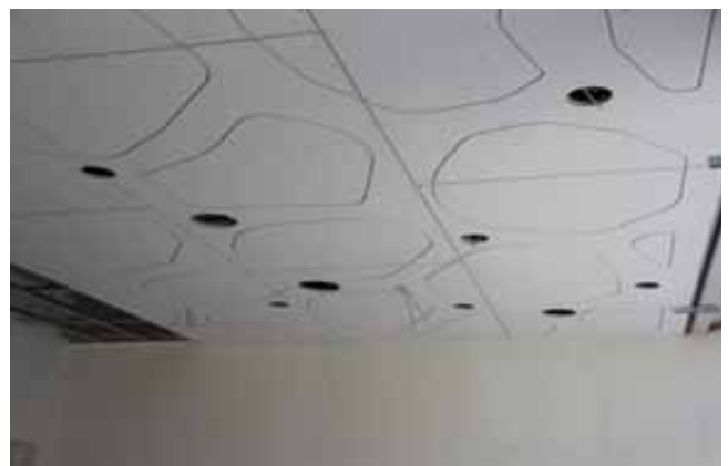
Decke nach dem Verspachteln und Schleifen der Fugen
