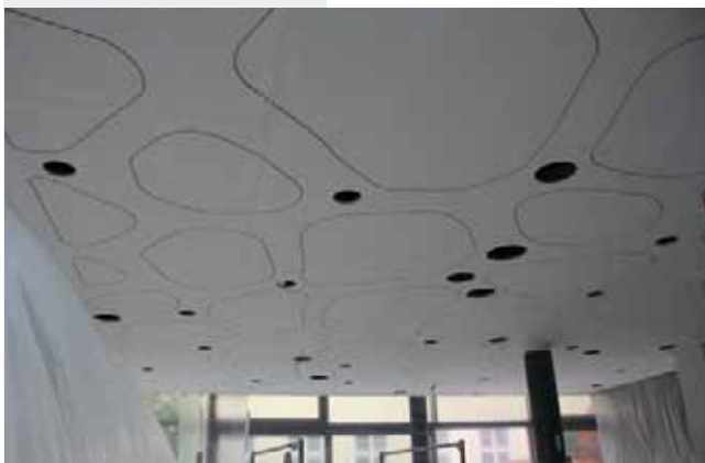
Decke nach dem Verspachteln und Schleifen der Fugen
